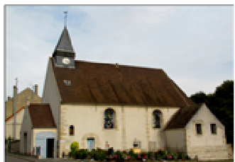
Église Saint-Joseph à Carrières
