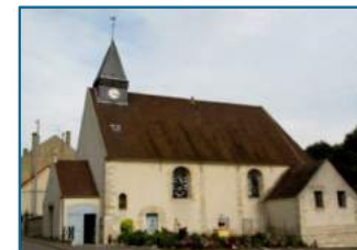
Église Saint-Joseph à Carrières
